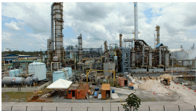
Fábrica de ácido sulfúrico em Camaçari – Bahia
